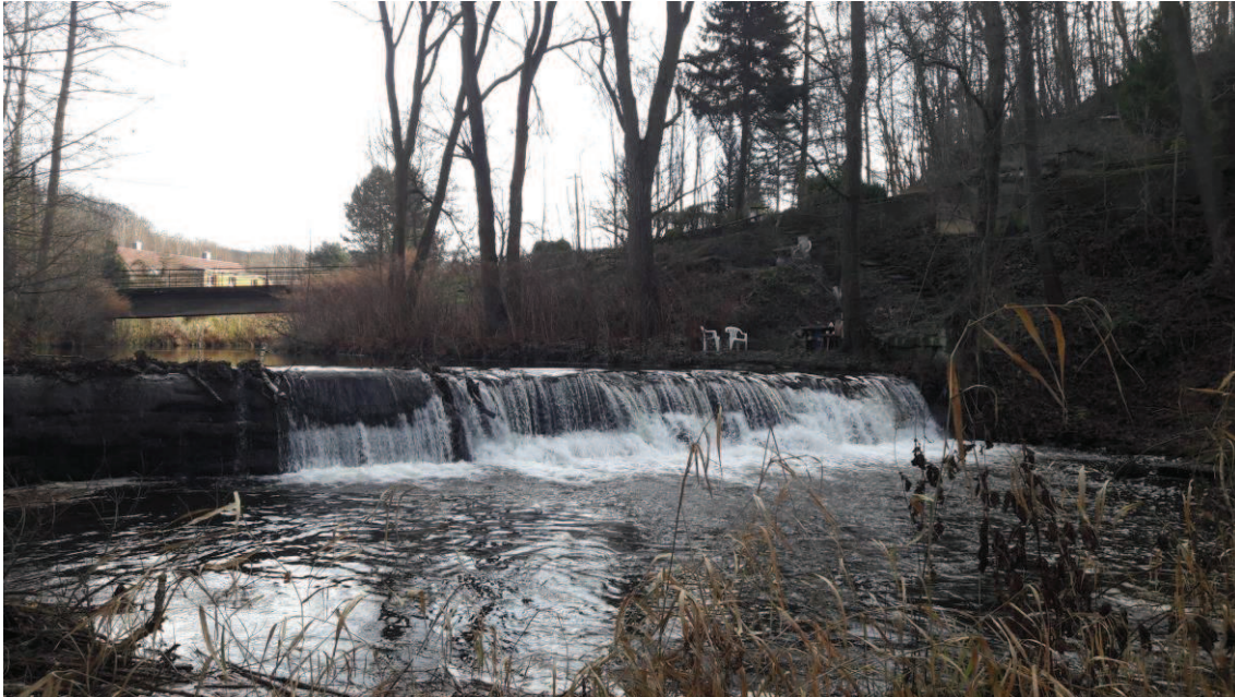
Abb. 27: An dieser Stelle soll das fischfreundliche Wehr in die Gottleuba gesetzt werden, links davon das Wasserrad (Kusic 2016).
